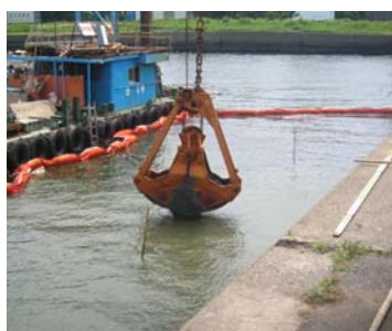
マウンド A 投入状況
