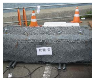
蛇籠 E ケース 5 天然碎石 対照区
